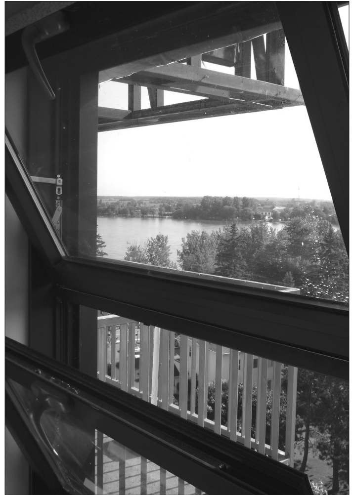
Les nouvelles fenêtres ont le défaut de basculer d'environ 12 pouces à l'intérieur des logements.
